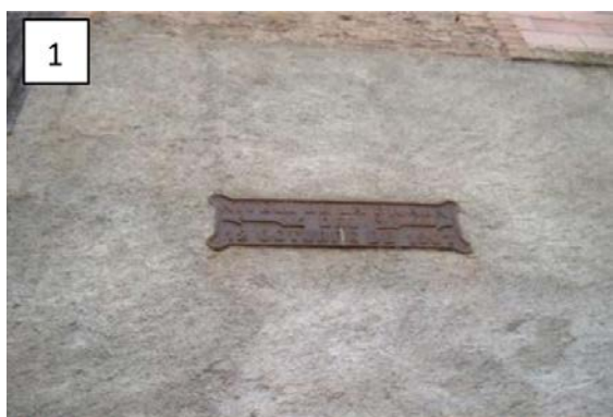
Figura 4. Marca de la inundació del 12/10/1907 situada a Callús - Façana de l'edifici (Font: ACA, foto del 10/04/2012)
