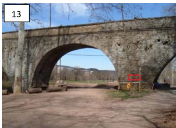
Figura 14. Marca de la inundació del 12/10/1907 situada a Manresa - Pont Nou o del Cementiri (Font: ACA, foto del 06/03/2012)
