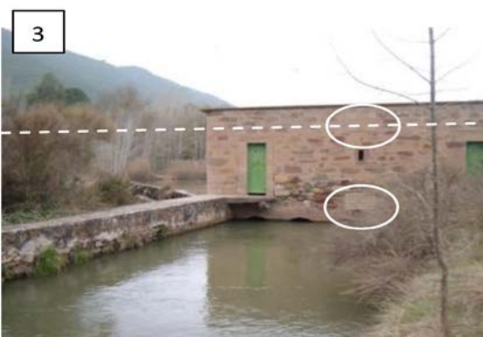
Figura 6. Marca de la inundació del 12/10/1907 situada a Callús – Presa fàbrica Cortès (Font: ACA, foto del 10/04/2012)
