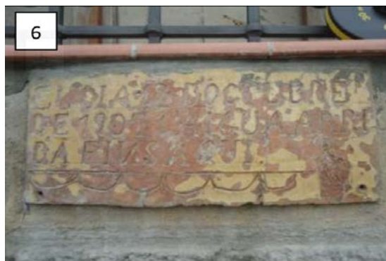
Figura 9. Marca de la inundació del 12/10/1907 situada a Súria - Placa ceràmica rectangular (diferent a la resta de plaques) (Font: ACA, foto del 08/05/2012)
