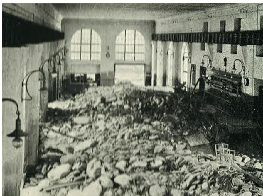
Figura 3 Danys a la sala de màquines de la central de la Torre de Cabdella (Fontserè i Galceran, 1938)
