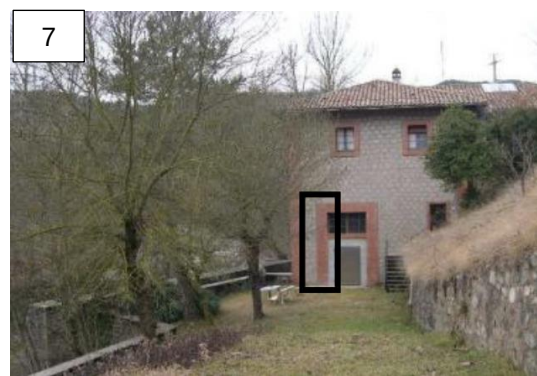
Figura 11. Marca de la inundació del 17/10/1940 situada a Castellbell i el Vilar – Estació d'aforament (Font: ACA, foto del 15/02/2011)
