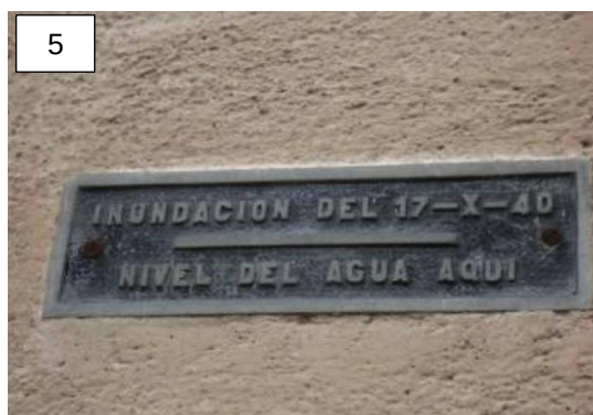
Figura 9. Marca de la inundació del 17/10/1940 situada a Les Llosses i Montesquiu - Als diversos edificis (Font: ACA, foto del 18/10/2016)
