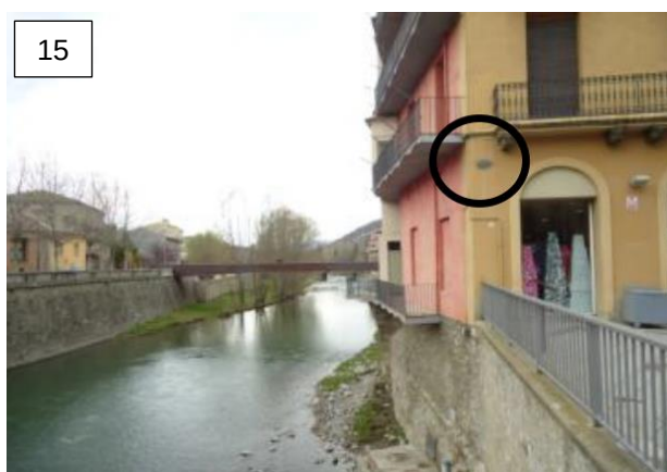
Figura 19 Marca de la inundació del 17/10/1940 situada a Ripoll - Marge dret del Ter (Font: ACA, foto del 29/03/2011)
