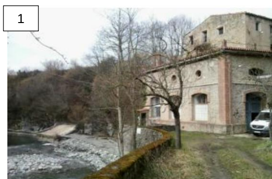
Figura 6. Marca de la inundació del 17/10/1940 situada a Sant Pau de Segúries – Central Hidroelèctrica Can Brandia. (Font: ACA, foto del 23/02/2016)
