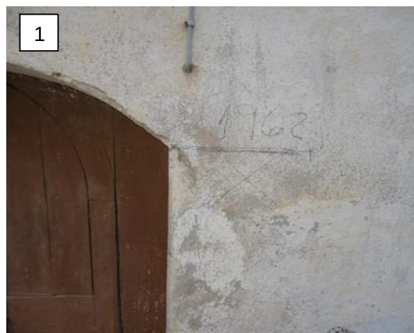
Figura 5. Marca de la inundació del 25/09/1962 situada a Gelida (Font: ACA, foto del 04/04/2011)
