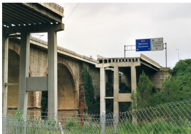
Figura 2. Pont de la N-II a l'alçada d'Esparreguera (Font: diari el Punt Avui)
