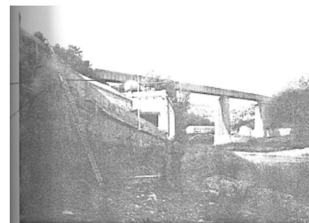
Rio Francolí en Picamoixons. Muro de la Papelera Española, donde está la señal de la avenida del 18-19 de Octu bre de 1930.
