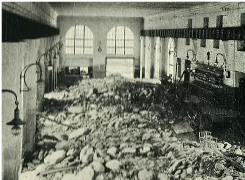
Danys a la sala de màquines de la central de la Torre de Cabdella
