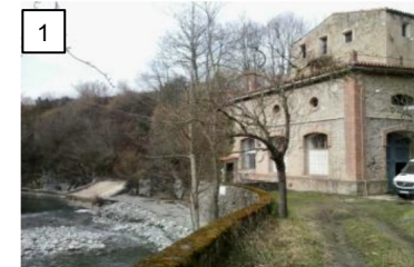
Situada Sant Pau de Segúries – Central Hidroelèctrica Can Brandia.(Font: ACA, foto del 23/02/2016)
