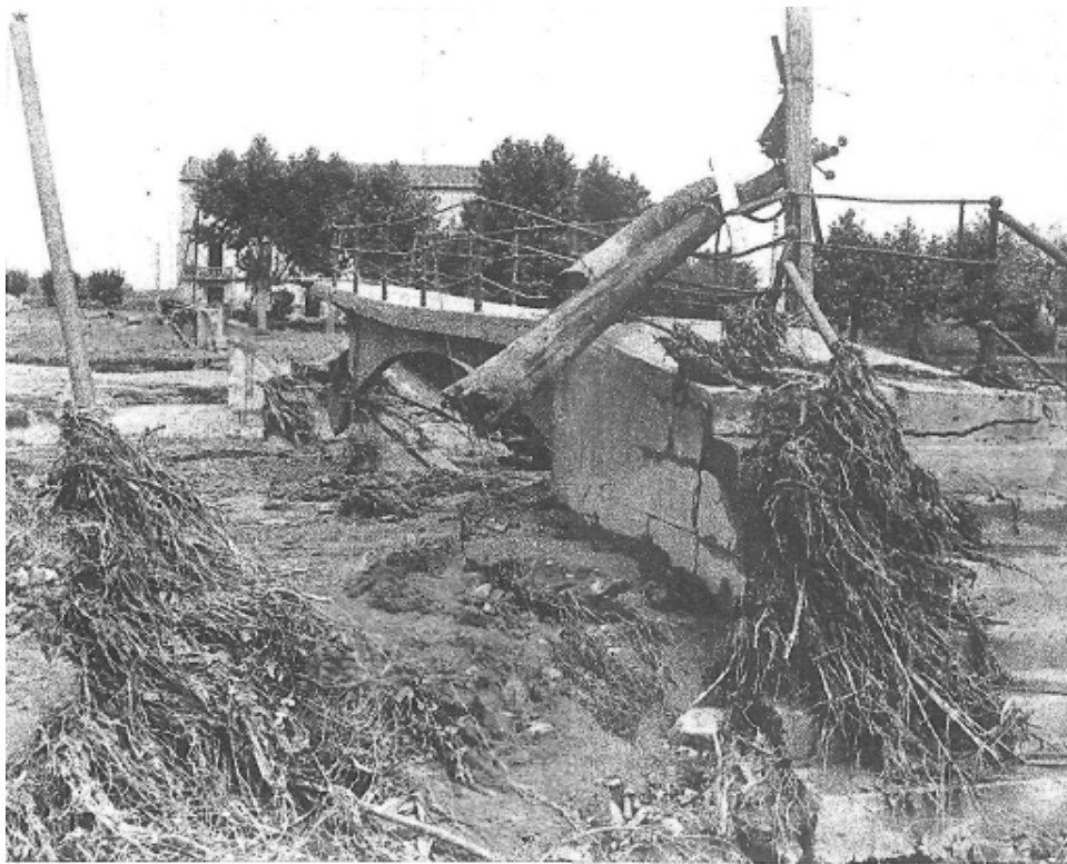
El puente para peatones que enlaza Montcada con Reixach, también destruido por las aguas
