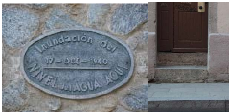
Figura 3. Marca de l'alçada de l'aigua en una inundació històrica i Doble esglaó que demostra el pas d'una riera en el passat.
