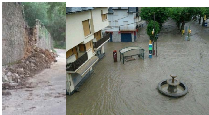
Figura 1. Efectes de les pluges sobre un mur i Inundacions de 2013 a la Vall d'Aran
