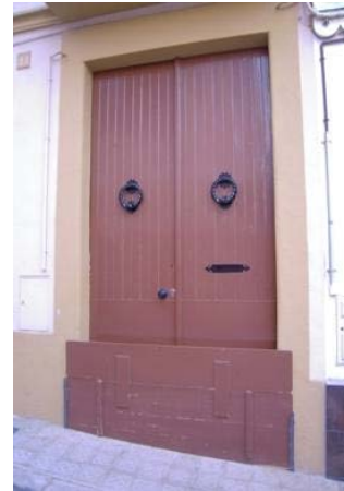
Fusta per evitar entrada aigua a l'edificació (Floodup)
