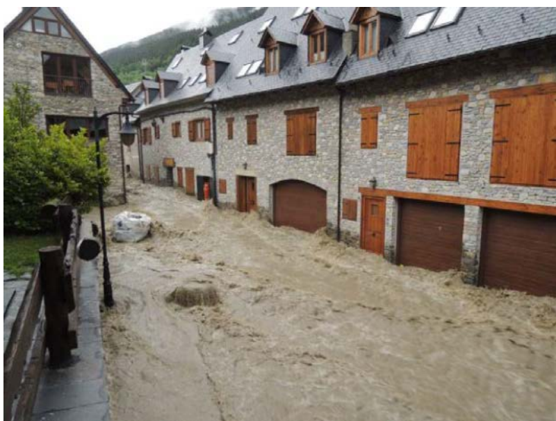
Figura 4. Inundació del carrer del Remei d'Arties (Font: Martín-Vide, 2013).
